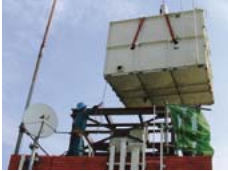
更新水槽組立工事
