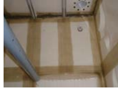
FRP補修工事 (水槽内)
