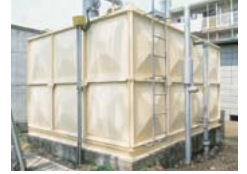
外観リフレッシュ塗装工事 (水槽外)
