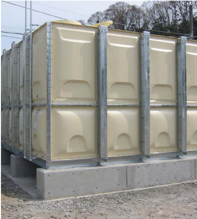
Fパネルタンク
