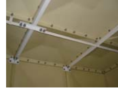
補強部材補修工事 (水槽内)
